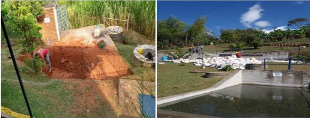
Con recursos propios se logró el cambio de las arenas de los cuatro (4) filtros rápidos de la planta La Soledad con un costo de \$8.348.400. La reposición de 4 válvulas HD de diámetro de 6" adquiridas por un monto de \$3.251.556 para lo cual
