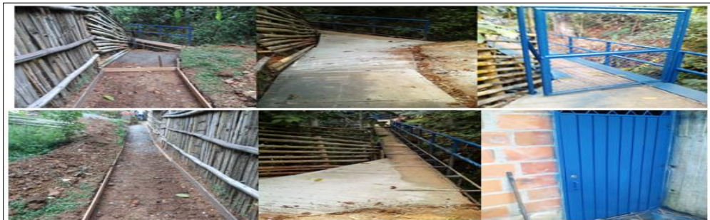
Foto No. 21 adecuaciones acceso e instalaciones internas
