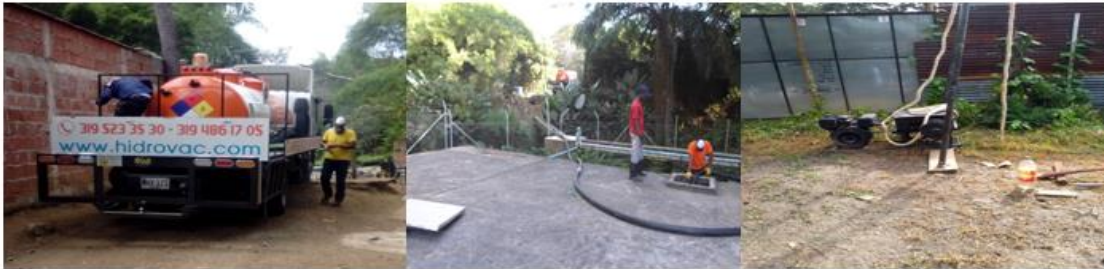
Foto No. 16. Evidencia extracción lodos PTAR EL Plan
