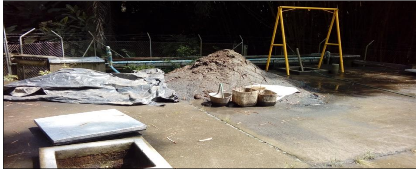
Foto No. 19. Extracción arena Tanque séptico
