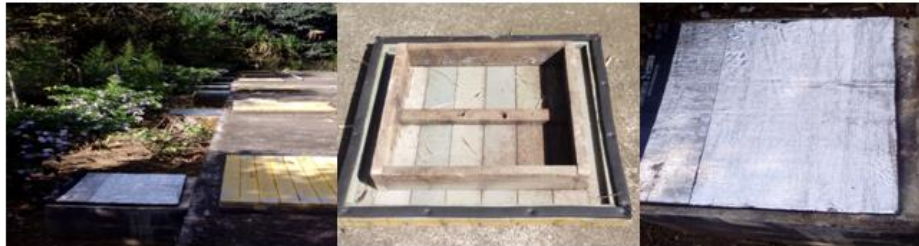
Foto No. 17. Evidencia sellamiento tapas PTAR
