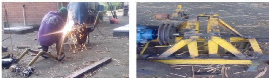
Foto No. 18. Arreglo base motobomba
