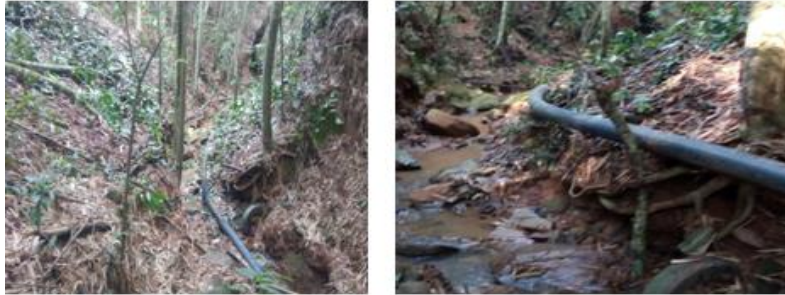
Foto No. 22. Evidencia mejoramiento descole
