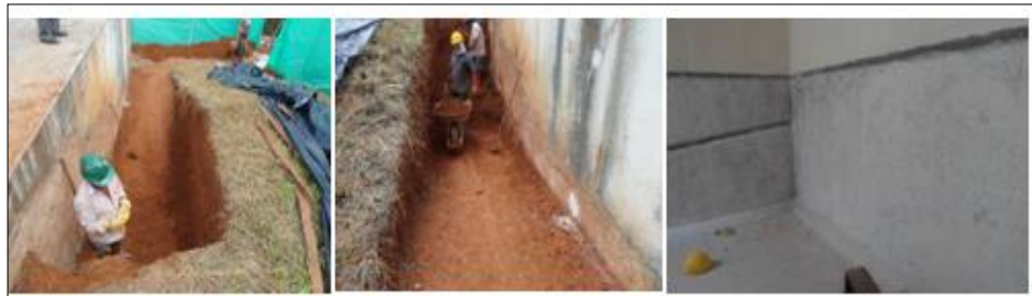
Foto No. 15. Actividades Tanque Almacenamiento La Buitrera
